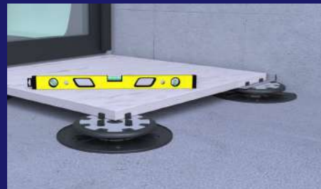
4° Nivelado de baldosa
