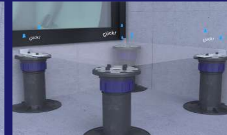
2° Eliminación de separadores en borde y esquina
