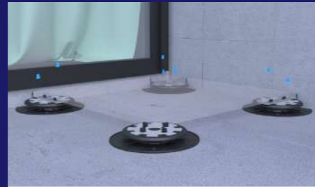
2° Eliminación de separadores en borde y esquina
