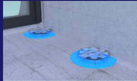
1° Corte de bases en borde y esquina
